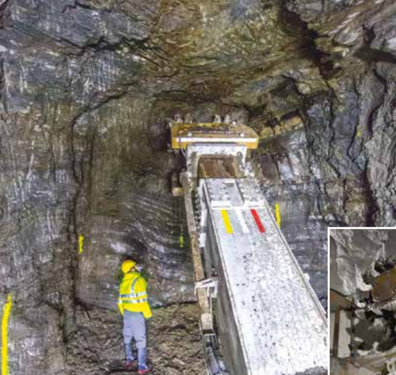
7 e 8. La portata idraulica della GTF 400 RC e il suo robusto braccio telescopico hanno permesso di sfruttare al meglio la capacità di scavo della testa fresante Simex TF 3000
