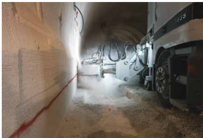
3 e 4. Grazie alla geometria del braccio la macchina può realizzare molto rapidamente canalette in verticale e orizzontale
