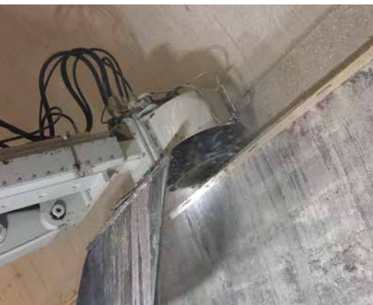
1. La GTF 250 RC può operare in posizioni particolarmente difficili
