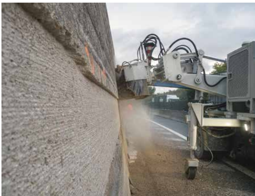
5. La GTF 250 RC è in grado di scarificare con grande precisione lasciando una superficie perfettamente aggrappante
