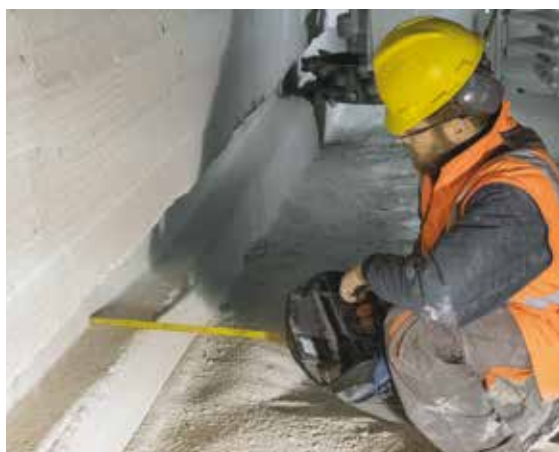
3 e 4. Grazie alla geometria del braccio la macchina può realizzare molto rapidamente canalette in verticale e orizzontale
