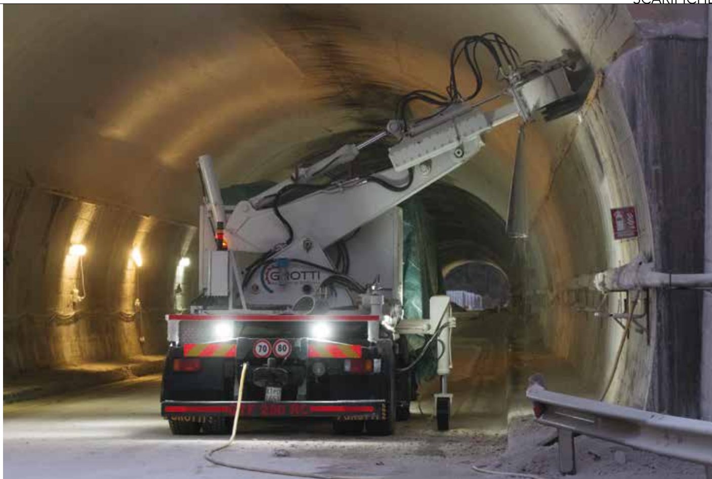
2. La macchina è caratterizzata da un modulo montato su autocarro costituito da un braccio articolato composto da due parti, di cui quella terminale è telescopica
