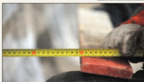
6 e 7. Fresature di 5 cm progressive sino ai 40 cm alla base dei piedritti
