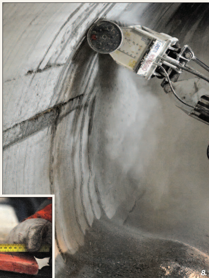
6 e 7. Fresature di 5 cm progressive sino ai 40 cm alla base dei piedritti
