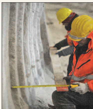
6 e 7. Fresature di 5 cm progressive sino ai 40 cm alla base dei piedritti
